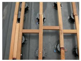
Si le niveau de la terrasse est nettement plus haut que le sol d'origine, on peut soit déposer sur sol damé des poutrelles de béton, tous les 70 cm en les mettant bien de niveau et en y fixant les chevrons.
