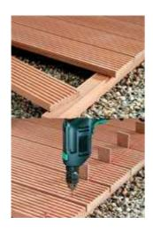
Les planches sont ensuite fixées sur les lambourdes, soit à l'aide de vis autoforantes en inox (2 vis sur la largeur de la planche par point de fixation), soit à l'aide d'attaches « invisibles ». Tendez un cordon pour un alignement parfait. Chaque extrémité de planche doit poser sur une lambourde et y être fixée.
