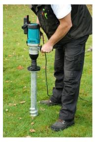
Placez la WEASYLECTRIC sur la tête de vissage et corrigez la verticalité de l'ensemble vis + machine à l'aide du niveau à bulle se trouvant sur la tête de vissage.
