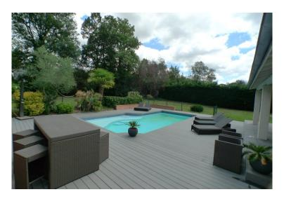
La fabrication consiste à mélanger des particules et fibres naturelles de bois avec du polyéthylène afin d'obtenir un produit composite renforcé et résistant à l'humidité. Il est conçu pour supporter tout type de climat, qu'il s'agisse de pluies torrentielles, de neige, de gel etc.
